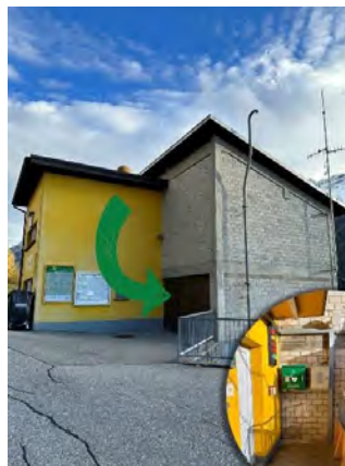
Frazione di Braggio, stazione di arrivo teleferica
