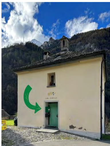
Frazione di Selma, ex casa Comunale
